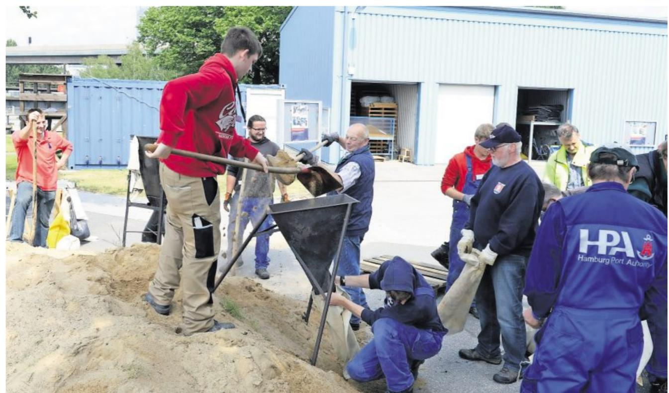
Das Befüllen von Sandsäcken ist zeit- und arbeitsintensiv. Daher ist es sinnvoll, Hilfsmittel einzusetzen. Zwei Helfer schaffen nach Erfahrungswerten der Akademie für Hochwasserschutz ohne Hilfsmittel etwa 50 Säcke pro Stunde, mit technischer Unterstützung das Doppelte. Fotos: Schult
