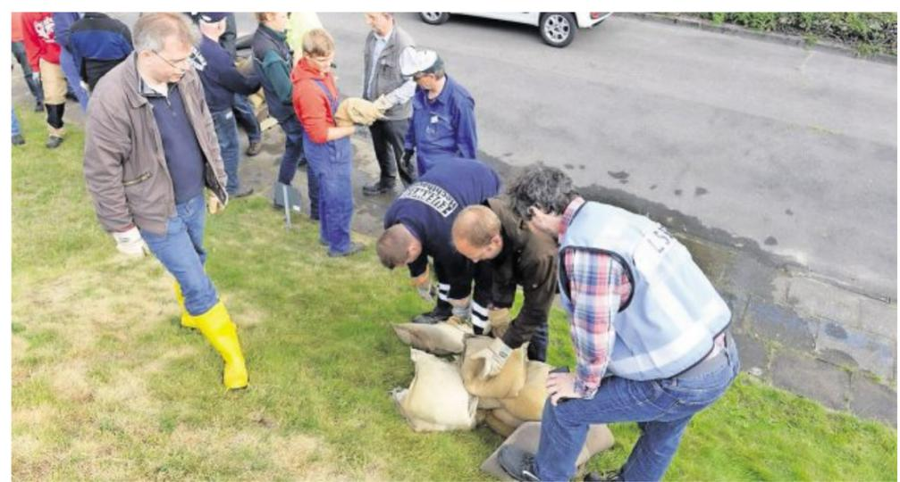
An dieser Station errichteten die Kursteilnehmer eine sogenannte Quellcade, um eine Sickerstelle im Deich so abzudichten, dass kein Material mehr austreten kann.
