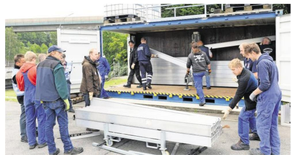
Auch das richtige Einsetzen von Dammbalken, etwa zum Verschließen von Deichlücken, will gelernt sein. Ob die Abdichtung auch hält, zeigte im Anschluss der Belastungstest mit Wasser.
