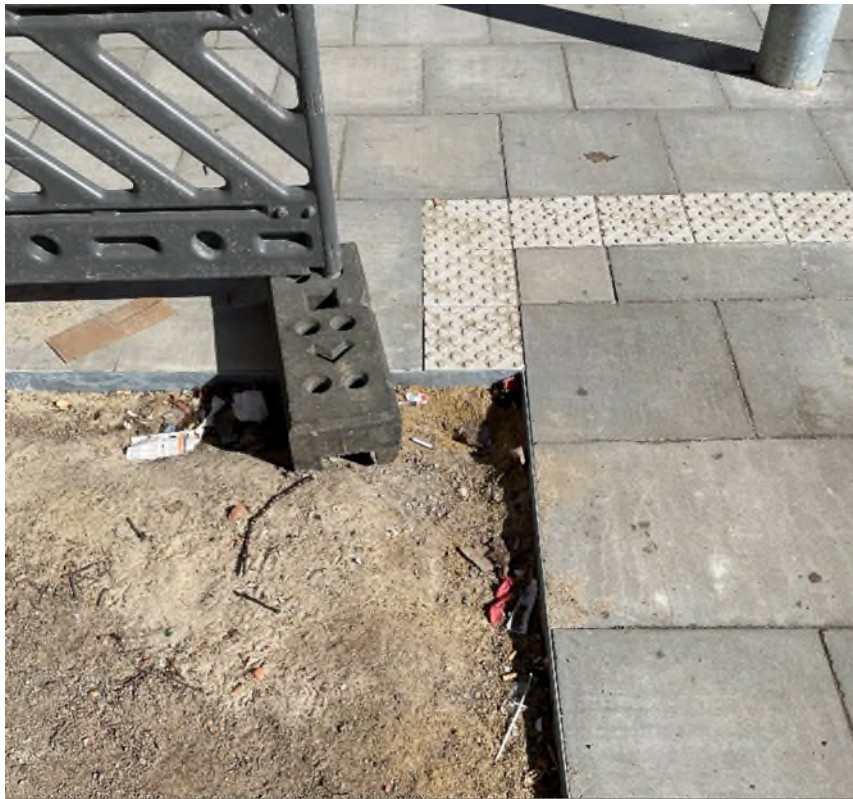
Abbildung 11: Beispiel eines Stahlbandes in Hamburg | Quelle: IPP
