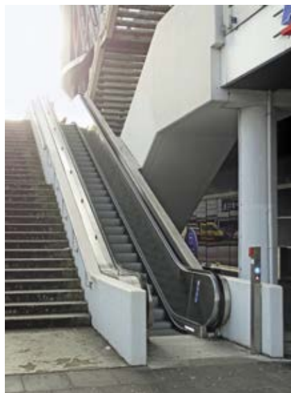
Die neue Fahrtreppe Adolph-Schönfelder-Straße
