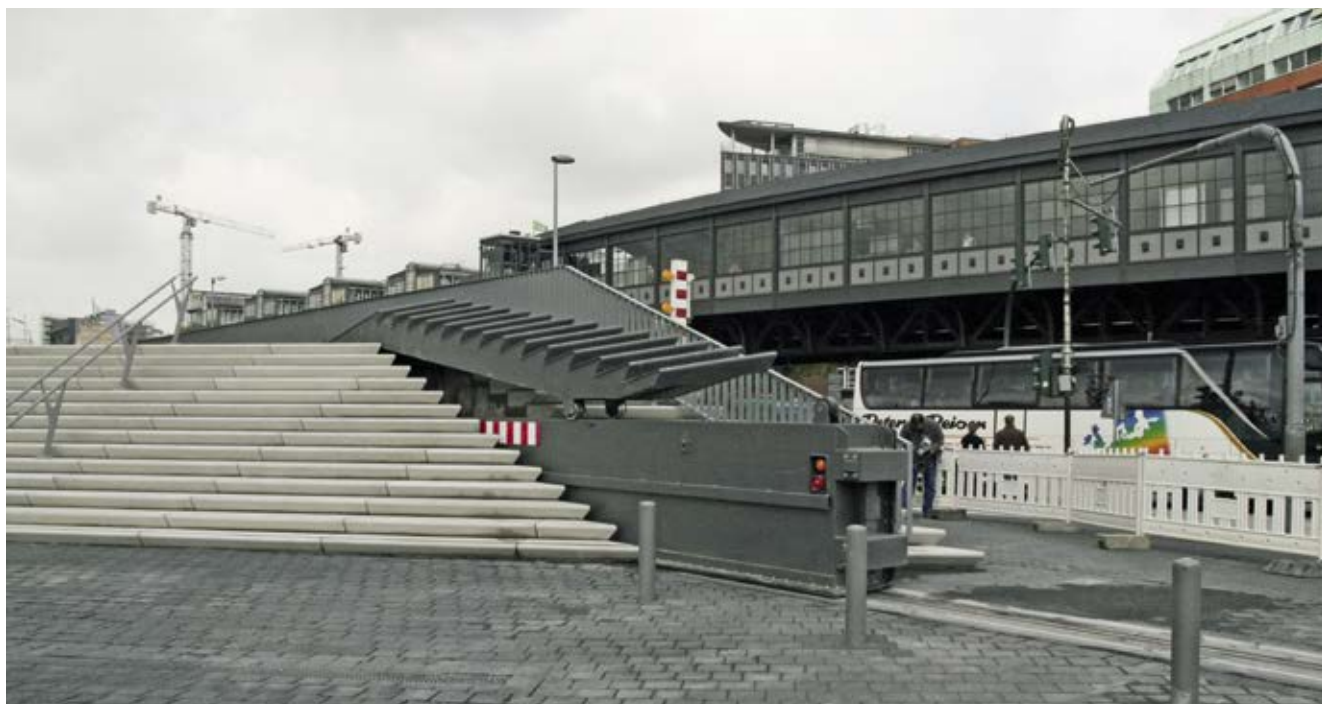
Hochwasserschutztor in der Promenadentreppe
