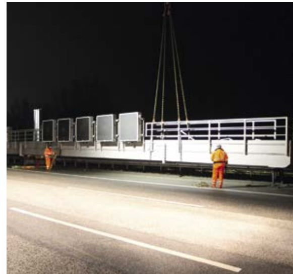
Montage der Schilderbrücken
