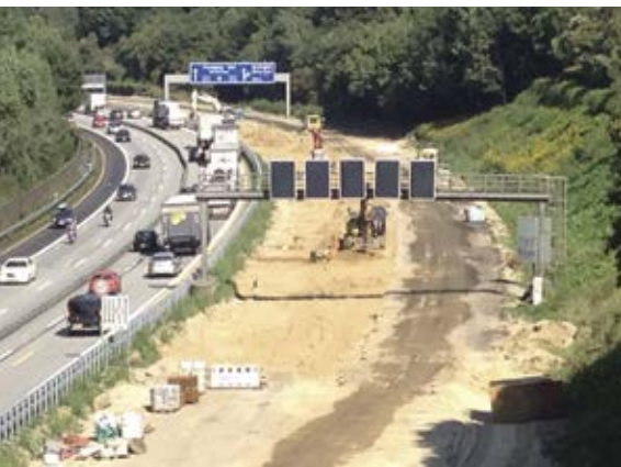
Aufbruch des Fahrhahnoberbaus
