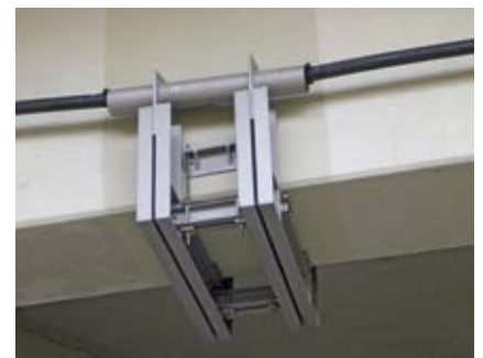
Umlenkkonstruktion für die externen Spannglieder
