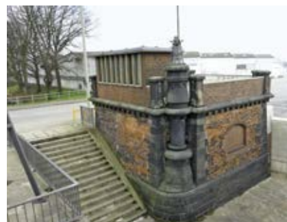
Blick vom aufgeständerten Geh- und Radweg auf das Böllerhaus
