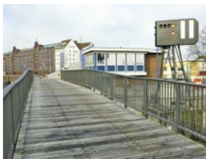
Brücke über die Hammerbrookschleuse
