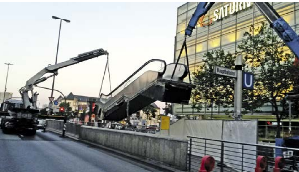
Demontage der Fahrtreppe Mönckebergstraße Süd im Sommer 2014
