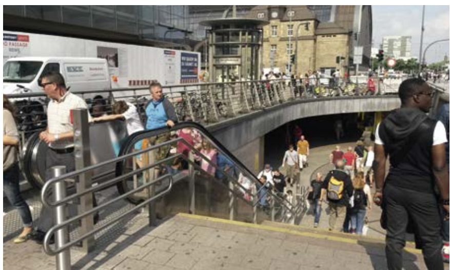
Fahrtreppe Mönckebergstraße Nord nach der Inbetriebnahme im Sommer 2014
