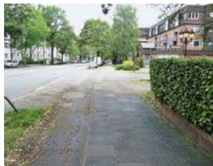
Fuhle im Bereich Ilandkoppel vor dem Umbau
