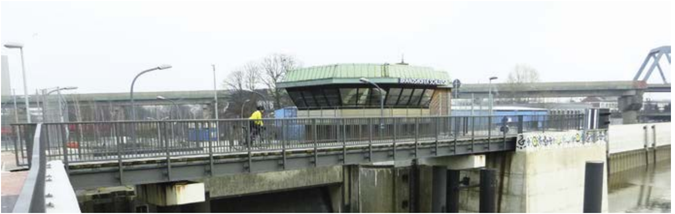
Brücke über die Einfahrt zur Brandshofer Schleuse – dahinter das Betriebshaus der Schleuse
