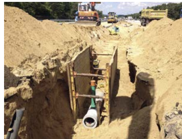
Neue Entwässerungsleitungen im Mittelstreifen
