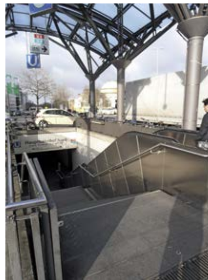
Die neue Fahrtreppe Spitalerstraße / Wandelhalle
