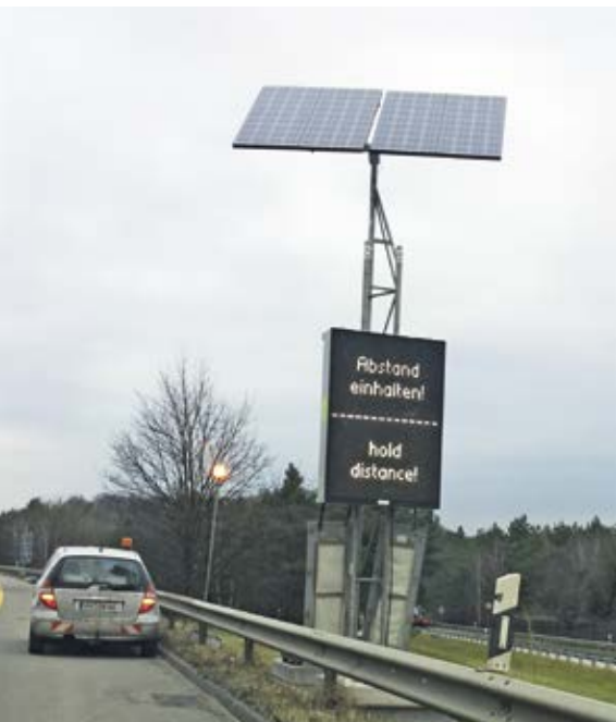
Dynamisch aufleuchtende LED-Tafeln in Kombination mit Abstandswarntmessanlage
