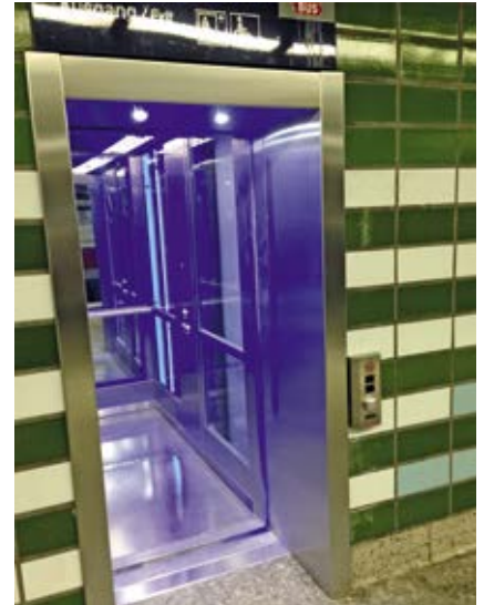
Aufzug Gleis 3 nach dem Umbau auf Bahnsteigebene
