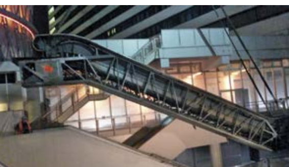
Demontage der Fahrtreppe Adolph-Schönfelder-Straße
