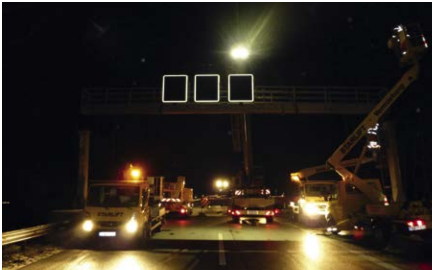
Aufbau der Schilderbrücken unter nächtlicher Vollsperrung der A1
