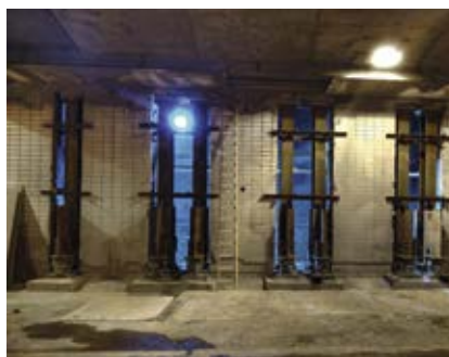
Elbtunnel –Tunnellüftung, Vorbereitung Stützen
