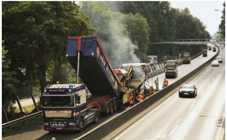
Einbau des offenporigen Asphalts
