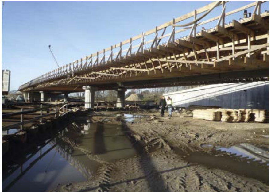
Umgehung Finkenwerder – Brückenbauwerk 02 über den Haakengraben
