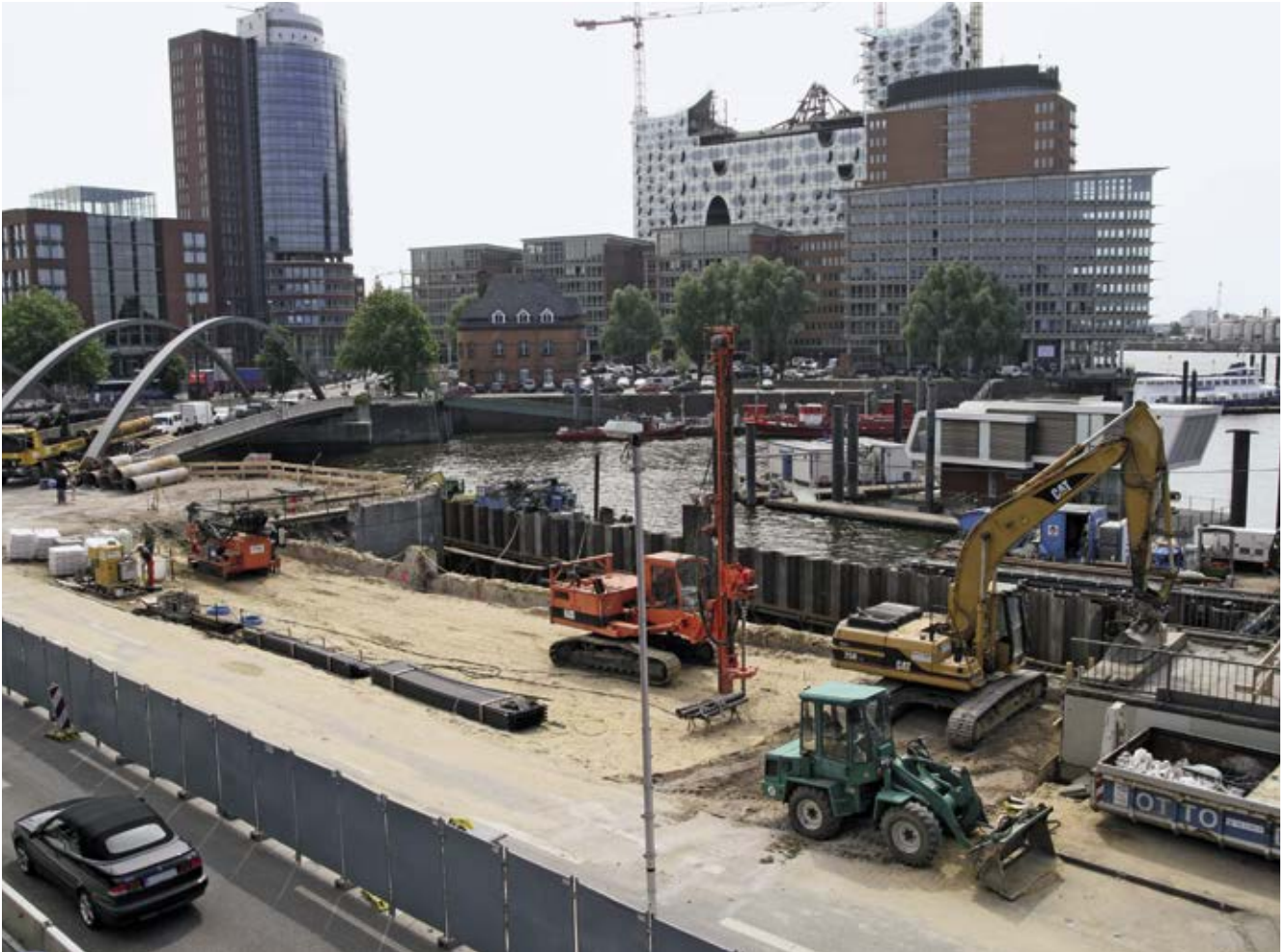
Baustelle am Baumwall
