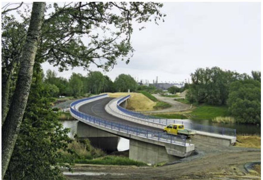
Umgehung Finkenwerder – Brückenbauwerk 01 über die Alte Süderelbe
