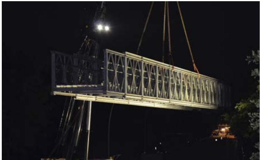
Einhub einer Monorail-Fahrschiene
