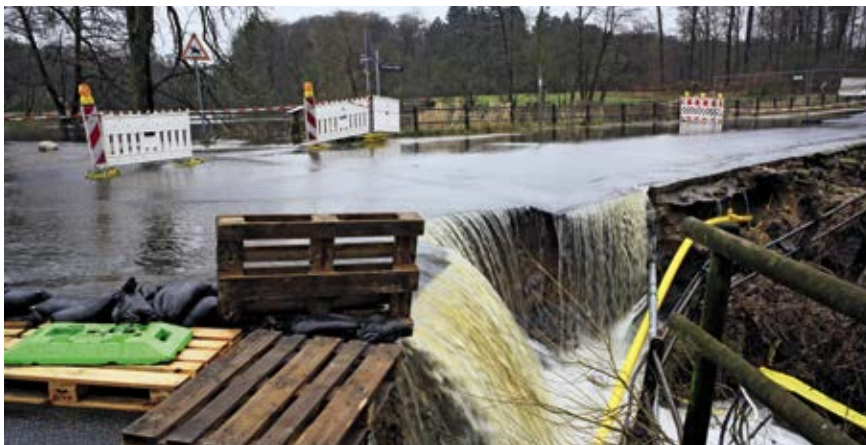
Überschwemmung Ammersbek Mühlenteich
