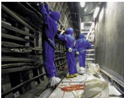
Elbtunnel – Asbestsanierung
