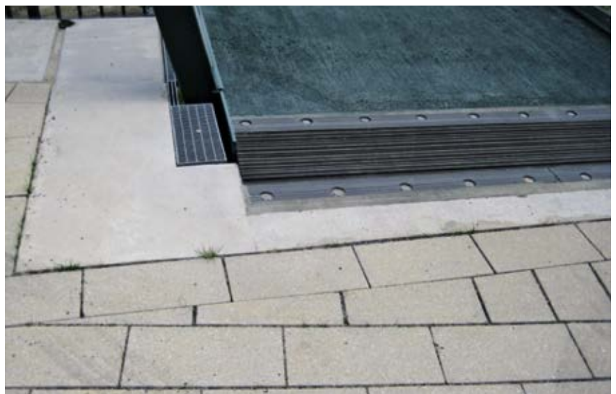
Fertiger Übergang Gertrud-von-Thaden-Platz zur Muharrem-Acar-Brücke
