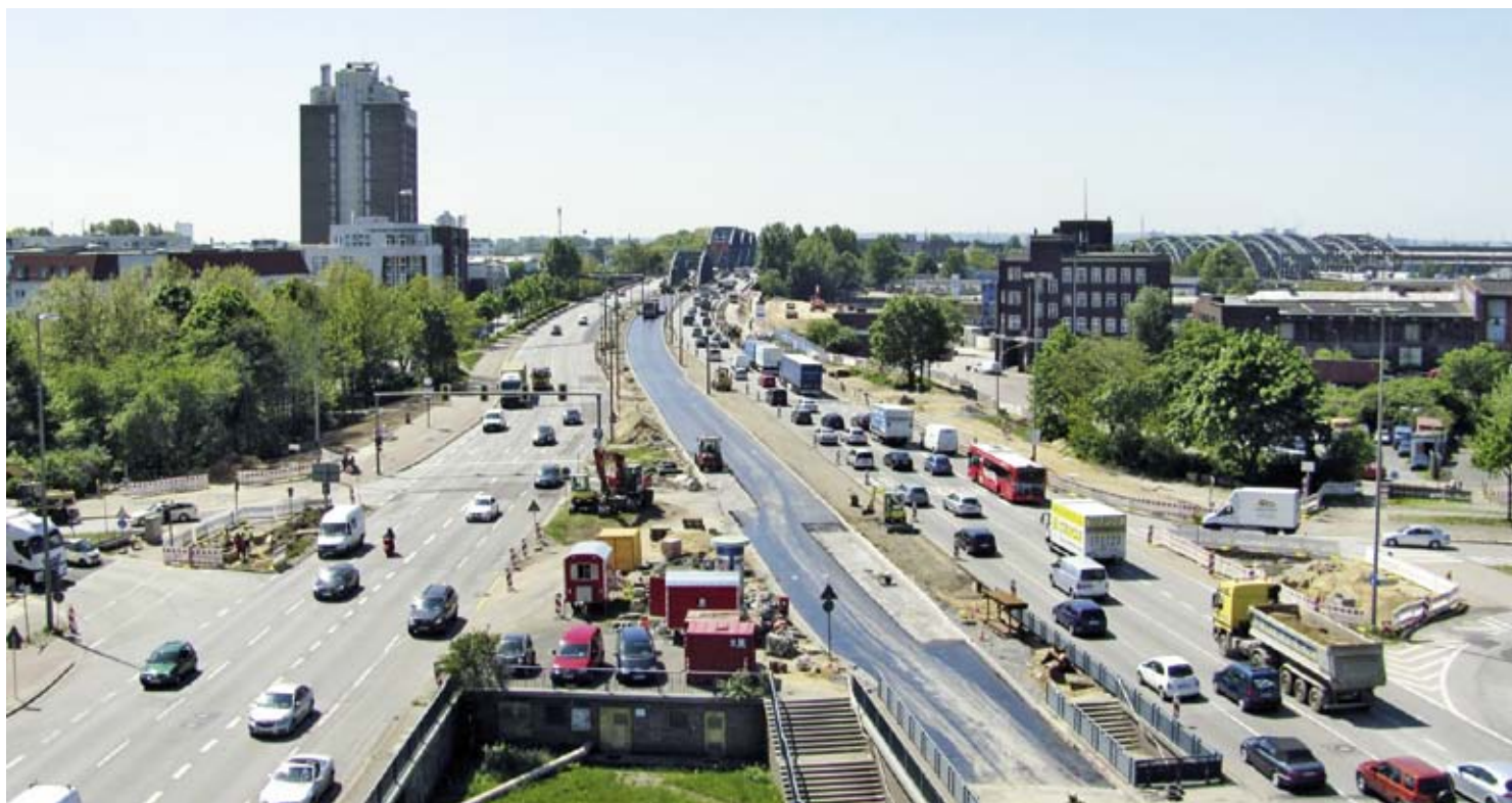
Billhorner Brückenstraße während der Bauarbeiten
