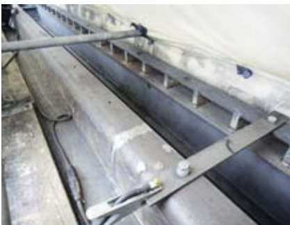
Neuer Schrammbordbereich, Vorarbeiten vor Aufbringen der Pufferschicht
