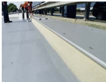
Neuer Schrammbordbereich, Vorarbeiten vor Aufbringen der Pufferschicht
