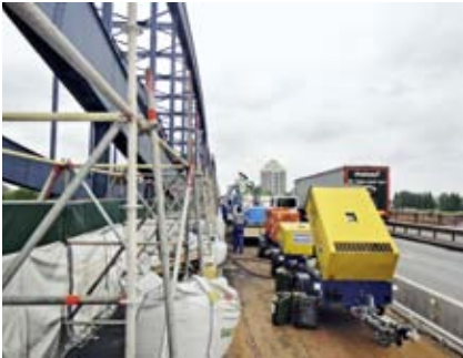
Linienbaustelle, beengte Arbeitsverhältnisse, Gerüstarbeiten unterhalb der Brücke
