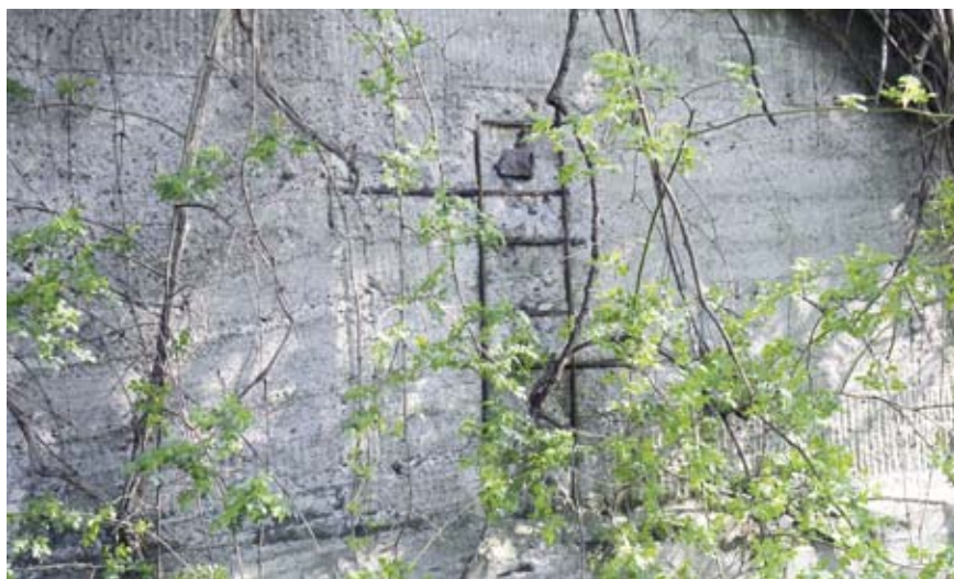
Großflächiger Betonabplatzung am Osterbekkanal
