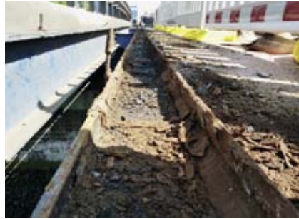
Korrosionsschäden an den Hauptträgern der Neuen Elbbrücke
