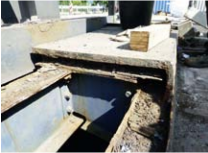
Korrosionsschäden an den Hauptträgern der Neuen Elbbrücke
