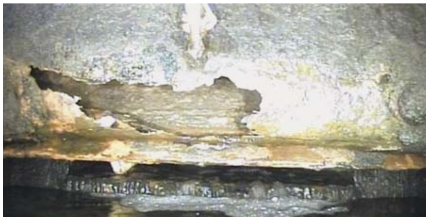
Großflächiger Betonabplatzung am Osterbekkanal
