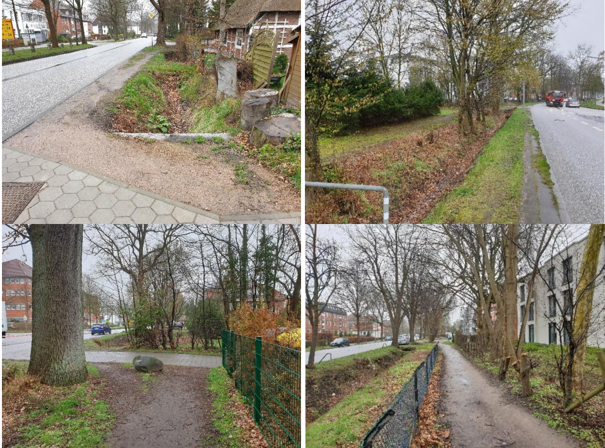
Abbildung 2: Beispielfotos Holsteiner Chaussee (links oben Station 0+090, Blickrichtung Nord, rechts oben Station 0+110, Blickrichtung Süd, links unten Station 0+170, Blickrichtung Nord, unten rechts 0+300, Blickrichtung Nord)
